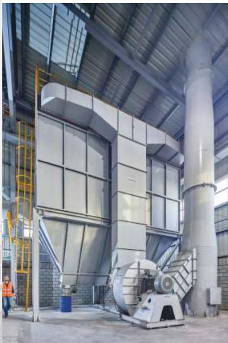
Дымы, собранные в вытяжной камере, фильтруются в рукавном фильтре.
