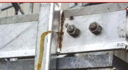
Kaynak kusması ve kaynak akıntısı
