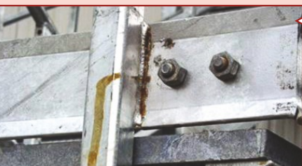
Kaynak kusması ve kaynak akıntısı
